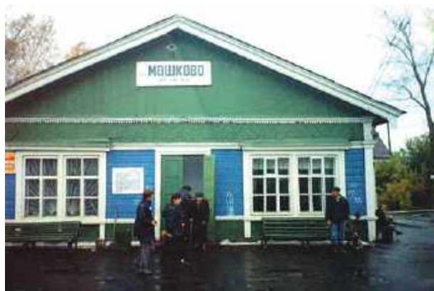
Фото 1995 г. Здание построено в 1898 г.
