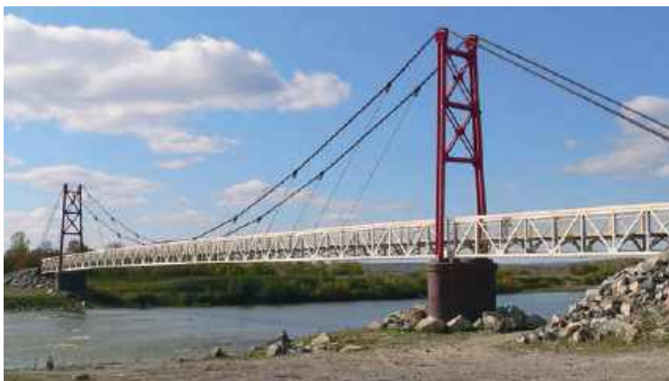
Мост с. Сарапулка
