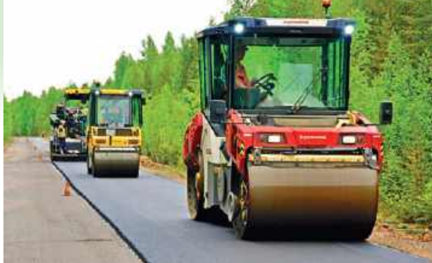
Ремонт автомобильных дорог
