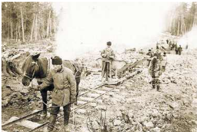
На строительстве железной дороги
