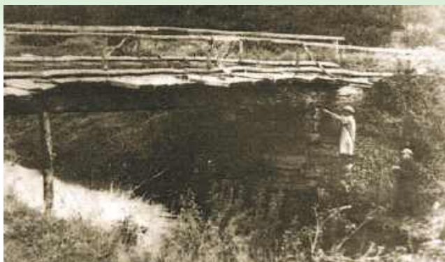
Мост через р. Ора с. Мотково
